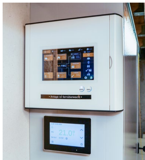
Eine Bildschirmanzeige dient unter dem Dach der Fernüberwachung der Heizung, im Keller stehen der Elektrokasten für den Zusammenschluss zum Eigenverbrauch (ZEV) und der Batteriespeicher.
