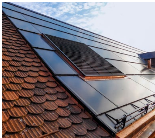
Eine Besonderheit des Anlagenkonzepts ist die Hinterlüftung der PV-Dachflächen. Auf den Bildern sind das Luftausblas- und das Luftansauggitter über der Regenrinne im Solardach zu sehen.
