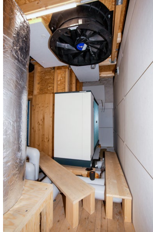
Die Luft-Wasser-Wärmepumpen wurden in einem schallisolierten Technikraum im Dach untergebracht. Davor wurde ein 2000 Liter fassender Wärmespeicher installiert.
