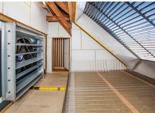
Eine Besonderheit des Anlagenkonzepts ist die Hinterlüftung der PV-Dachflächen. Auf den Bildern sind das Luftausblas- und das Luftansauggitter über der Regenrinne im Solardach zu sehen.
