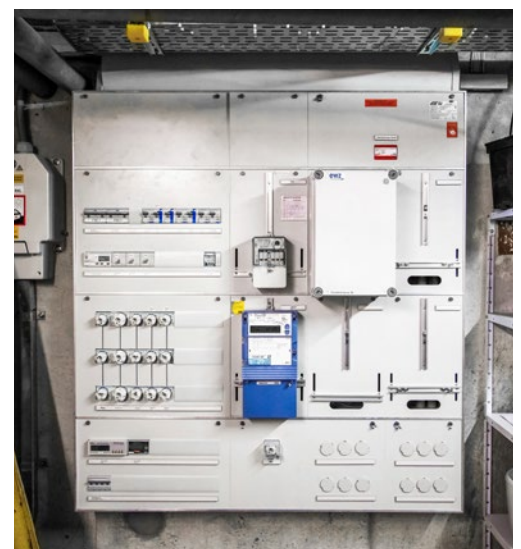
Eine Bildschirmanzeige dient unter dem Dach der Fernüberwachung der Heizung, im Keller stehen der Elektrokasten für den Zusammenschluss zum Eigenverbrauch (ZEV) und der Batteriespeicher.
