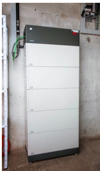
Eine Bildschirmanzeige dient unter dem Dach der Fernüberwachung der Heizung, im Keller stehen der Elektrokasten für den Zusammenschluss zum Eigenverbrauch (ZEV) und der Batteriespeicher.
