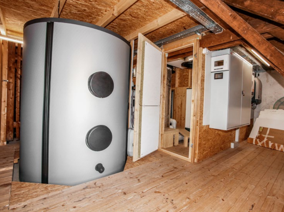
Die Luft-Wasser-Wärmepumpen wurden in einem schallisolierten Technikraum im Dach untergebracht. Davor wurde ein 2000 Liter fassender Wärmespeicher installiert.
